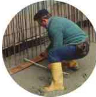
La réalisation d'un simple gabarit simplifie le positionnement des chevilles.
