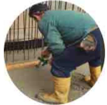
Il ne reste plus qu'à introduire la cheville Kombi-TITAN avec le bouchon Kombi-FIX 45 dans le béton frais à l'emplacement prévu.
