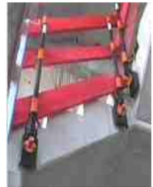
Des garde-corps vissés et ancrés, un plus pour la sécurité.
